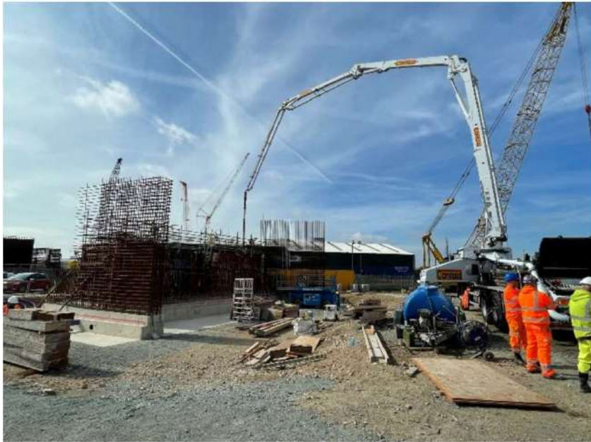
North Abutment Concrete Pour
