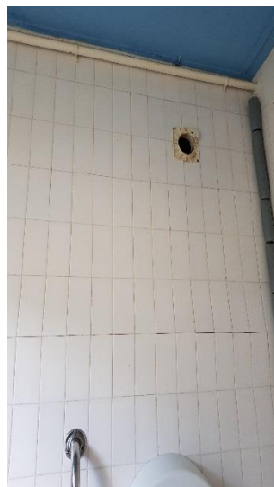
20. Broken Air Vent
