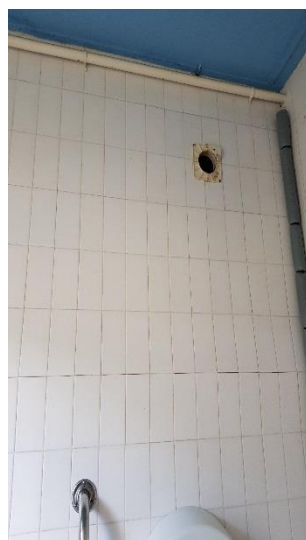
20. Broken Air Vent
